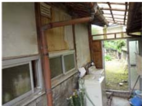
土壁は剥がれている また地盤が沈んでいる
