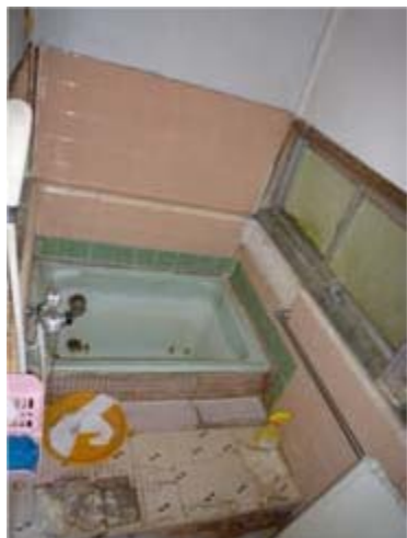
土壁は剥がれている また地盤が沈んでいる
